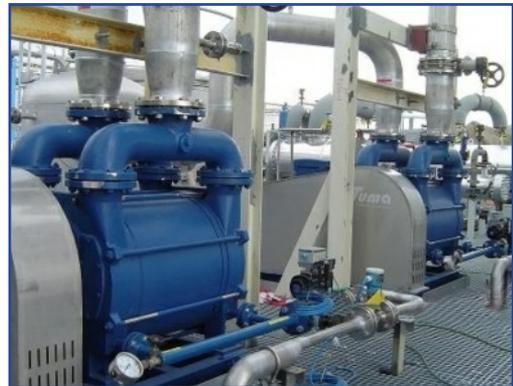
**Vakuumanlage für NMP-Recycling**
