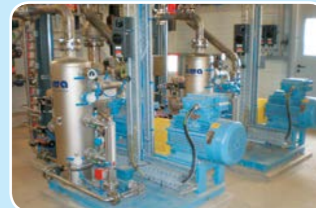
Hochdruck Flüssigkeitsring Kompressoren High Pressure Liquid Ring compressors Series TUD, TUG2, TUH, TUH2 Förderleistung / Capacity: 150 – 2500 m³/h bis 12 bar
