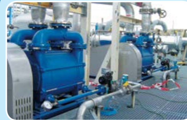
Einsatz: Chem. Industrie / Application: Chem. Industry Förderleistung: 5000 m³/h / Suction Capacity: 5000 m³/h
