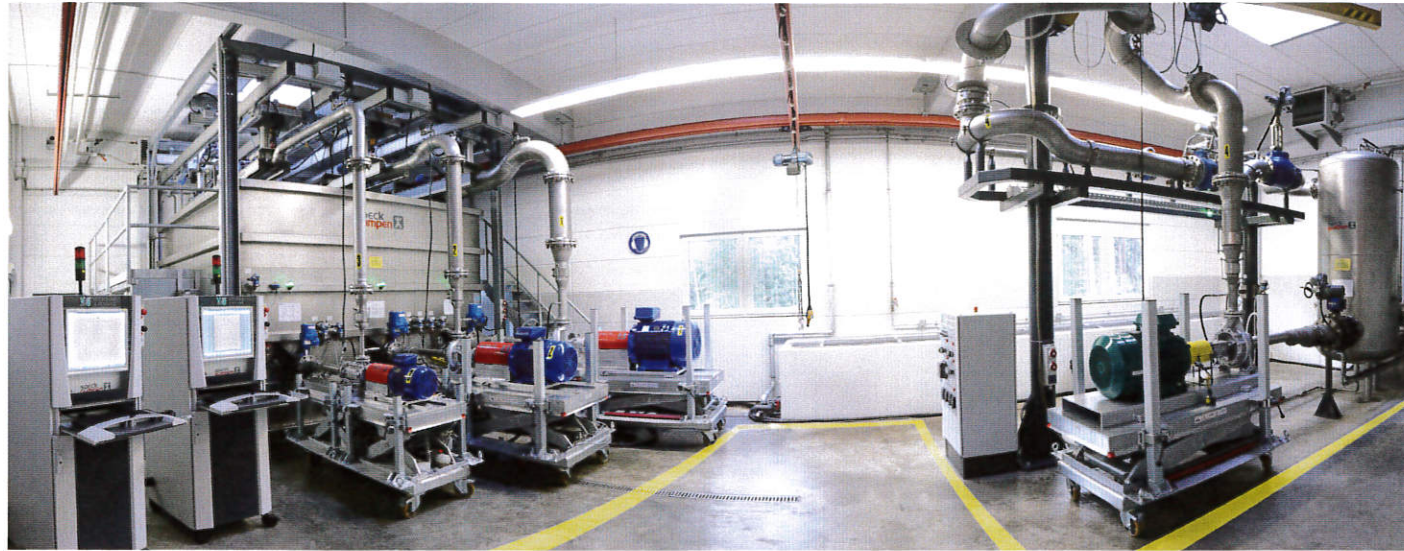
Computergesteuerte und vollautomatisierte Prüfstände im Werk von Speck Pumpen in Roth. Messung von Hydraulik, Leistungsbedarf, Axialschub, Schwingungen und NPSH-Werten. Förderhöhen bis 400 m und Fördermengen bis 750 m 3 /h möglich.
