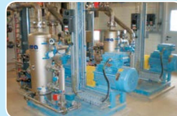
**Hochdruck Flüssigkeitsring Kompressoren**
